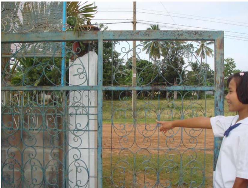
จุดที่ 10 ประตูต่อเดือนทางเข้าอาคารเรียนเกิดการล้มทับบาดเจ็บได้
