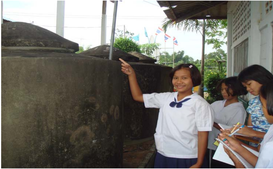
จุดที่ 1 ถังปูนซีเมนต์เก็บน้ำฝนที่มีความห่วยและตะไคร่น้ำจับ
